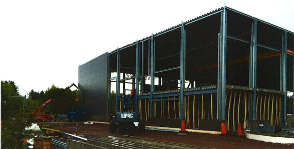
Figur 1. Arbetsytan i samband montage av väggelement på norra gaveln, 140513
